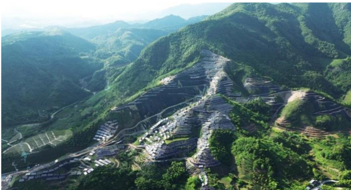
Figur 6 Den kinesiska solcellsparken (dec. 2024) med betesmark under solpanelerna.
